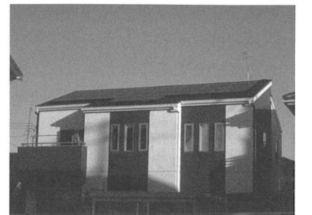
磯崎邸 (4.2kW) の発電システム
