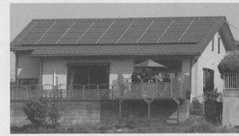
↑「省エネの工夫などをしてわが家の光熱費の自給率を140%にしました(システム容量6.5kW)。(会員番号A08195827)のシステム
