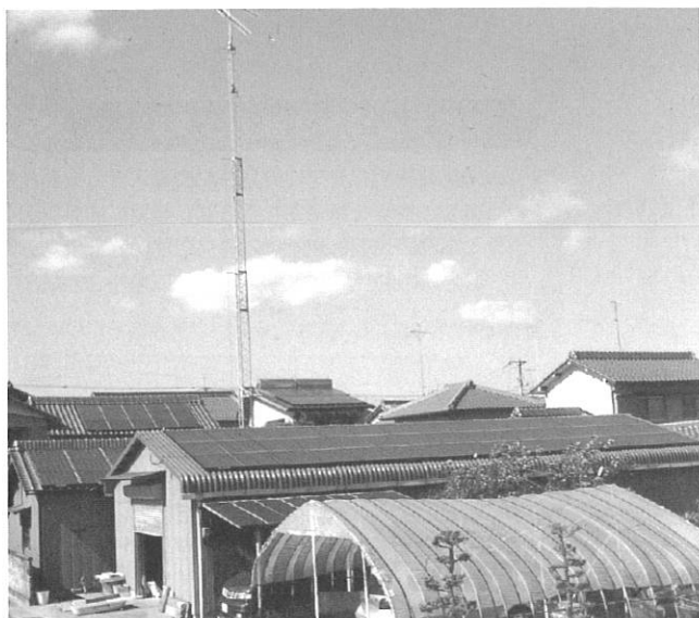
太陽熱温水器発電とパネル
