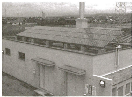
甲府市南部市民センターの太陽光発電所
