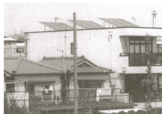
太陽光発電システム設置当時、建物南側(写真手前)は広いテニスコートだったため、発電はすこぶる好調。1997年8月撮影。
