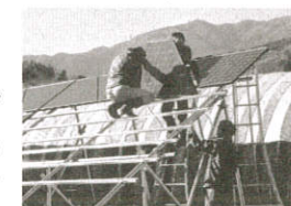
パネル取り付け
