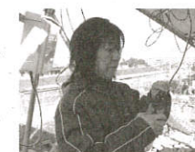
端子取り付け作業（圧着）
