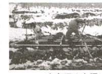
土台埋め穴掘り
