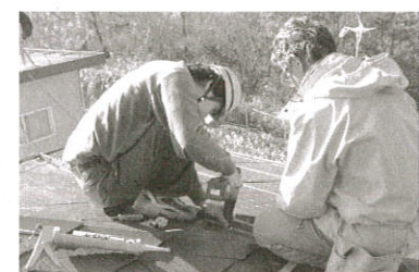
手づくり発電所工事の様子(アングルの取り付け)
