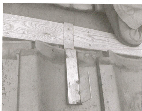
←和瓦屋根に取り付けられたエコテック独自開発の金具
