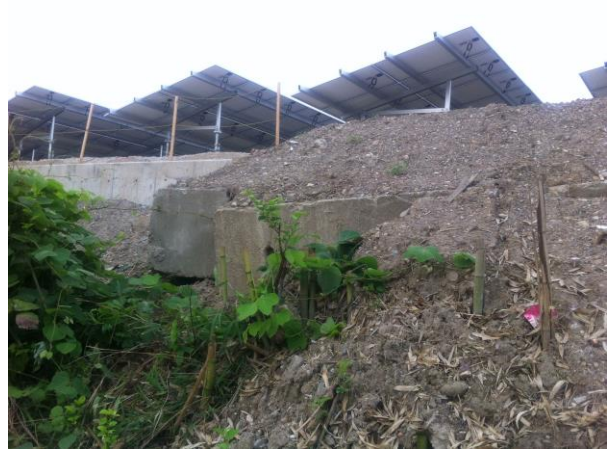
堤防道路(擁壁用コンクリート製ブロック放置)
