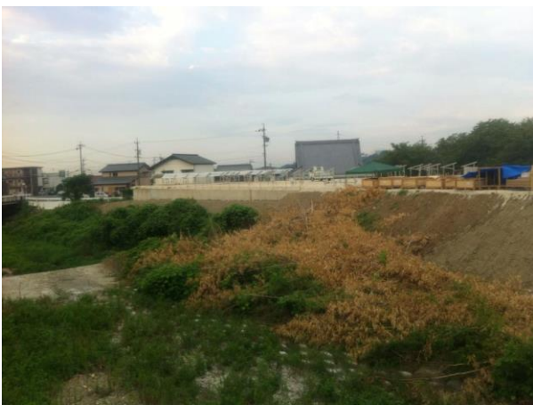
新坂下橋南側(土砂投棄)
