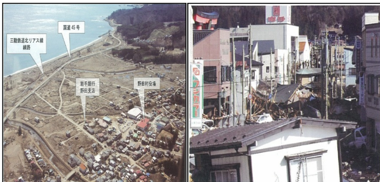
2011.3.11 野田村の被災状況
