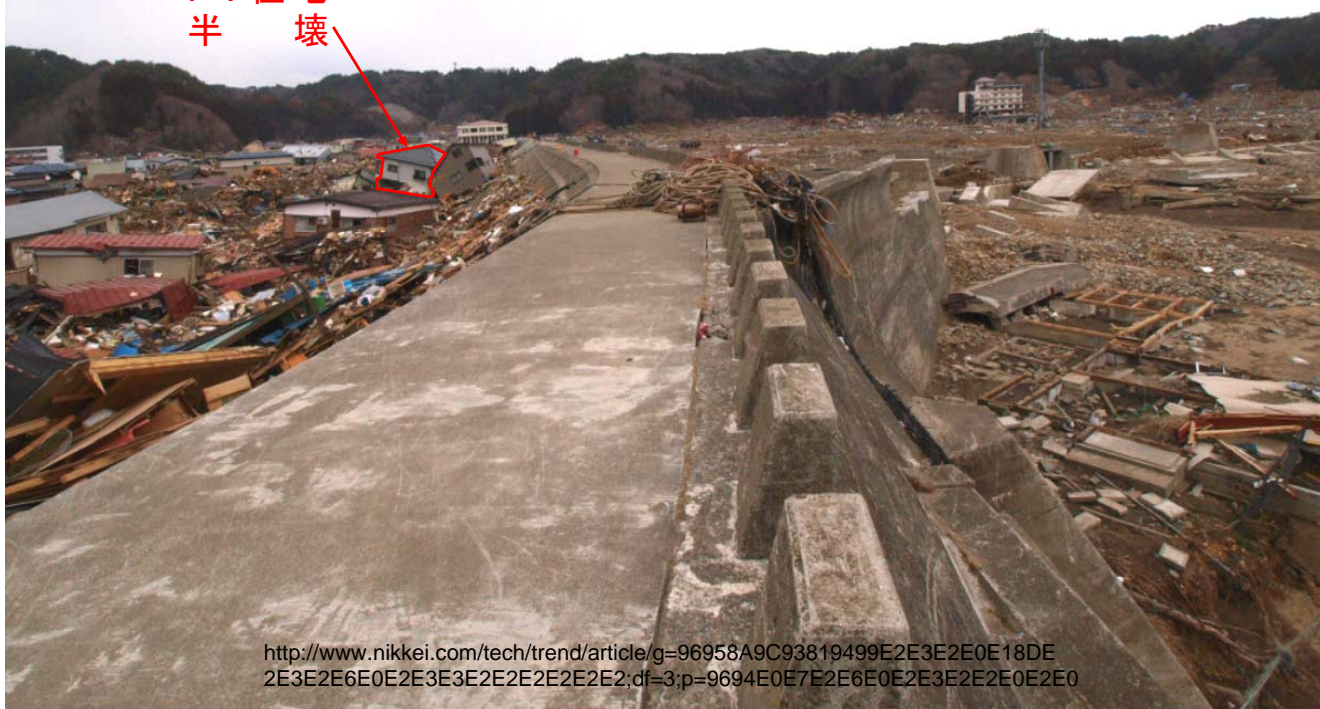
写真の左奥に向かうのが北方向の陸側防潮堤。右に向かうのが東方向の海側防潮堤だが、津波で崩壊した(写真:日経コンストラクション)
